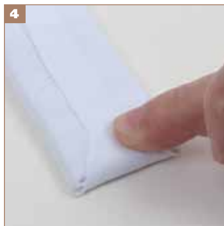
4 Подогните и закрепите край при помощи клея для дерева.
